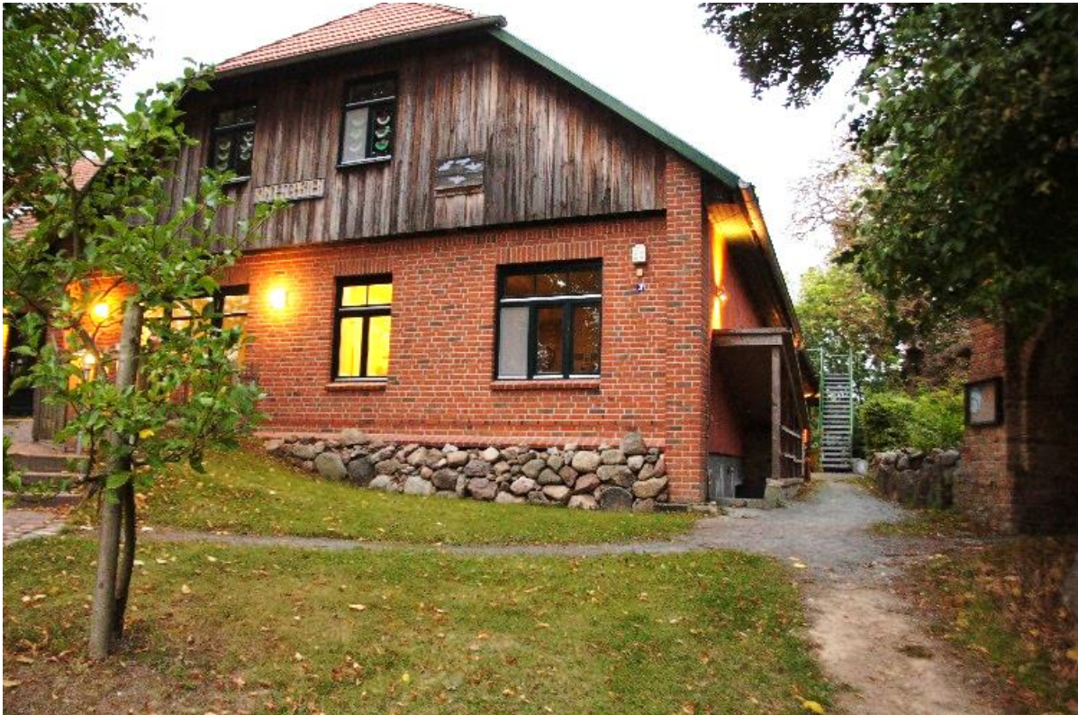
Eingangsbereich der Kita mit nördlichem/rechtsseitigem zweitem Zugang
